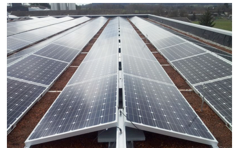
Abbildung 6: Aufbau der Photovoltaikanlage nach Ost/West Ausrichtung
