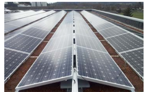
Abbildung 6: Aufbau der Photovoltaikanlage nach Ost/ West Ausrichtung
