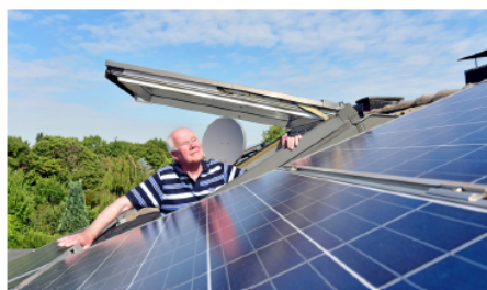
Walter Kleinöder mit seiner Photovoltaik-Anlage auf dem Dach seines Wohnhauses am Nansenweg. FOTO: JÖRG SCHIMMEL / FFS
